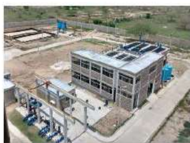
Foto 3. Planta de Tratamiento de Agua Potable (PTAP) Manatí
