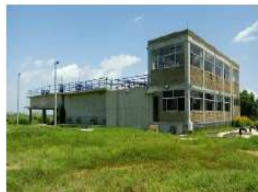
Foto 4. Planta de Tratamiento de Agua Potable (PTAP) Manatí
